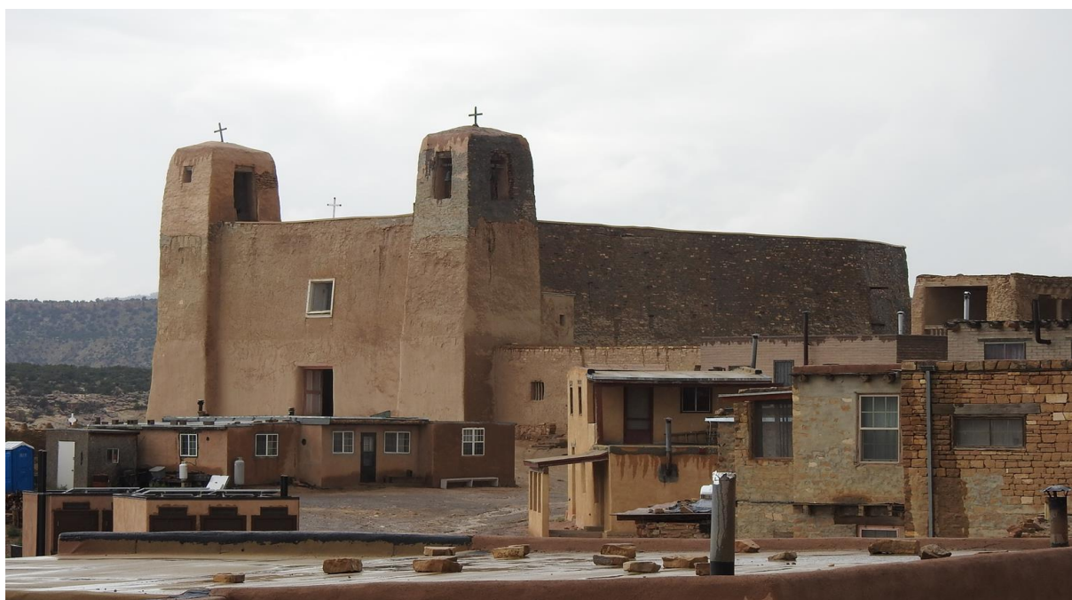
Zbudowany w 1629 roku z kamienia i cegły adobe franciszkański kościół misyjny pod wezwaniem San Estevan del Rey. Kościół wzniesiono w miejscu zburzonej największej kivy puebla w celu walki z lokalnymi wierzeniami Acoma. Na przeciwko kościoła znajduje się cmentarz, na którym zmarli pochowani są na kilku poziomach z uwagi na brak miejsca na terenie mesy (zakaz fotografowania).
