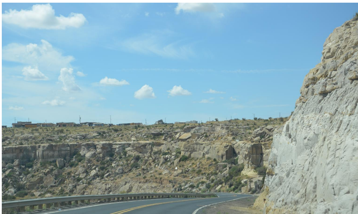
Droga dojazdowa do osiedli na Trzeciej Mesie
